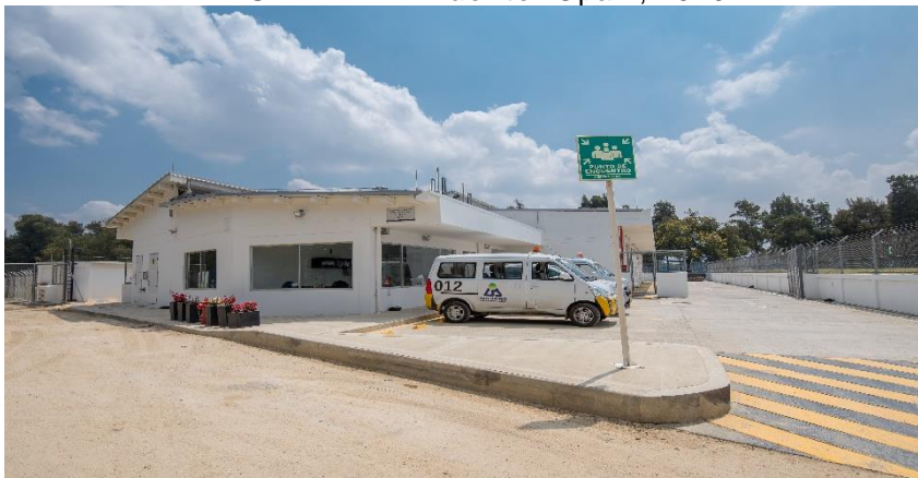
ILUSTRACIÓN 25. Estación de Clasificación y Aprovechamiento – ECA Fuente: Opain, 2020
