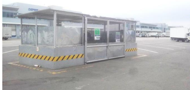
ILUSTRACIÓN 8. Centro de Acopio de residuos en terminal de carga
