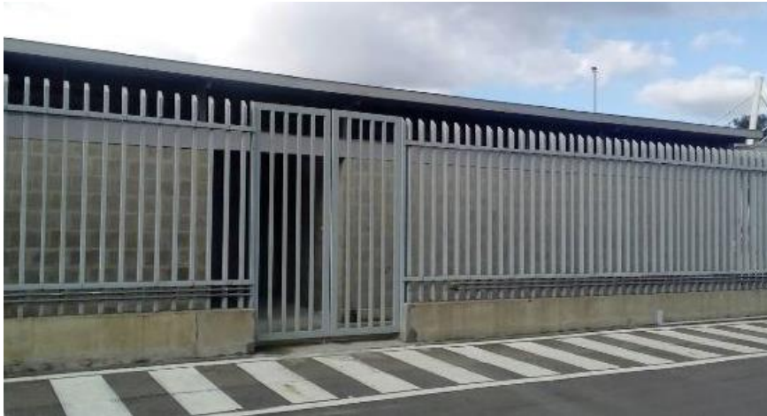
ILUSTRACIÓN 18. Centro de Almacenamiento Temporal de Residuos Terminal de Carga B – CATR TC B Fuente: Opain, 2020
