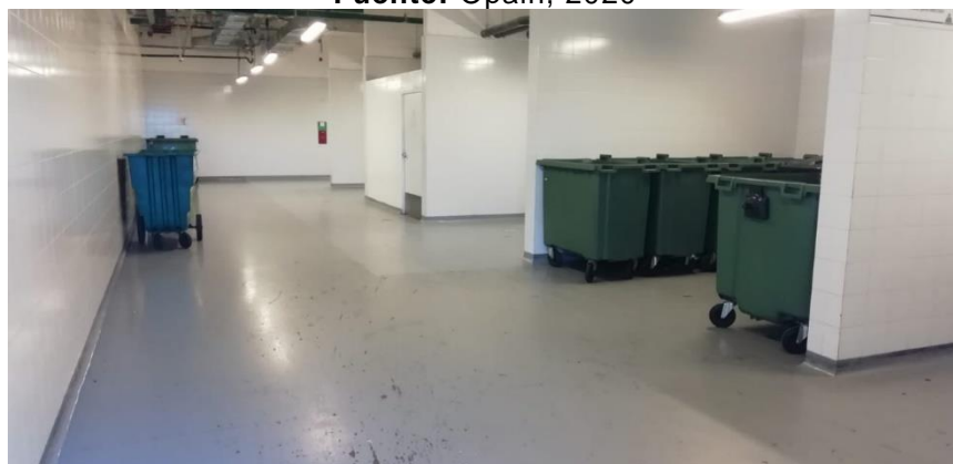
ILUSTRACIÓN 23. Centro de Almacenamiento Temporal de Residuos Terminal 1 D – CATR T1 D Fuente: Opain, 2020
