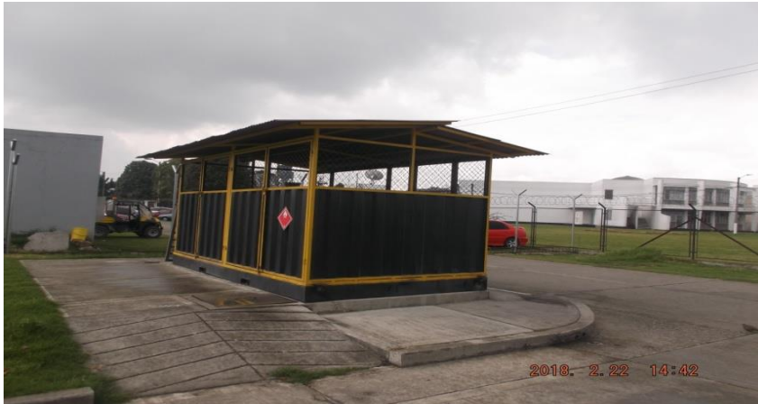
ILUSTRACIÓN 24. Centro de Almacenamiento Temporal de Residuos Peligrosos ARFF – CAT RESPEL ARFF Fuente: Opain, 2020
