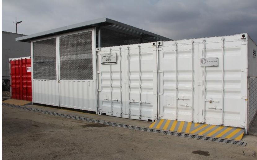
ILUSTRACIÓN 16. Centro de Almacenamiento Temporal de Residuos T2 – CATR T2 Fuente: Opain, 2020
