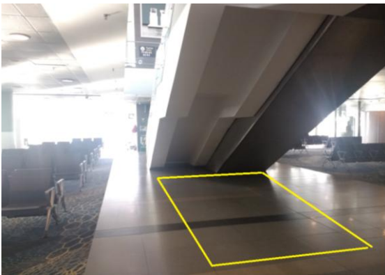
Muelle Nacional: Salas 80-83 debajo de las escaleras eléctricas nivel 4.70.
