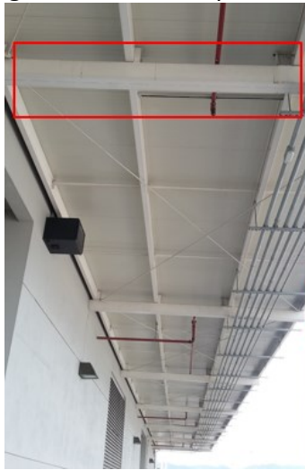
Figura 1. Vigas en donde se aplicará el repelente
