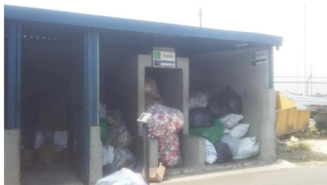
Ilustración 8. Almacenamiento de residuos aprovechables en el Centro de Almacenamiento Temporal de Residuos - CATR Fuente: Elaboración propia, febrero 25 de 2016
