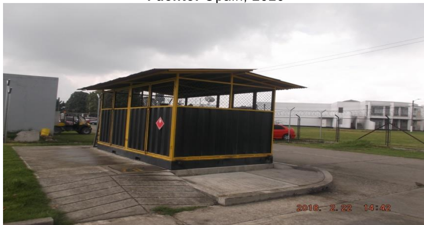
Ilustración 23. Centro de Almacenamiento Temporal de Residuos Peligrosos ARFF – CAT RESPEL ARFF Fuente: Opain, 2020
