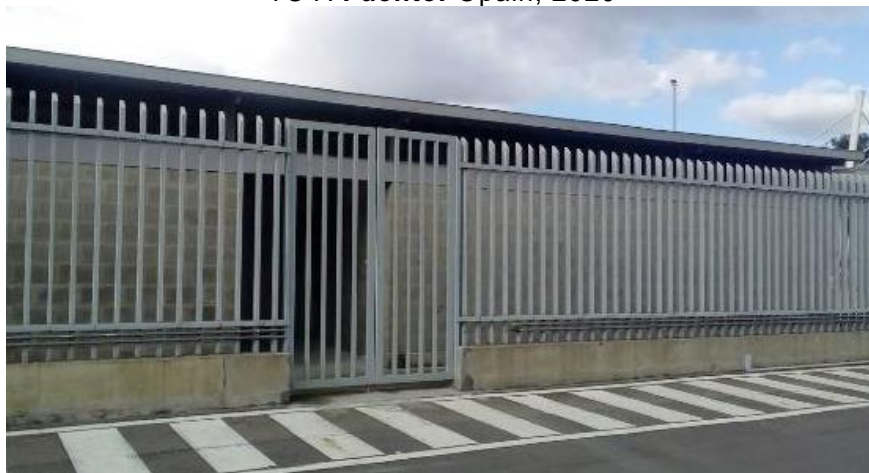
Ilustración 17. Centro de Almacenamiento Temporal de Residuos Terminal de Carga B – CATR TC B Fuente: Opain, 2020
